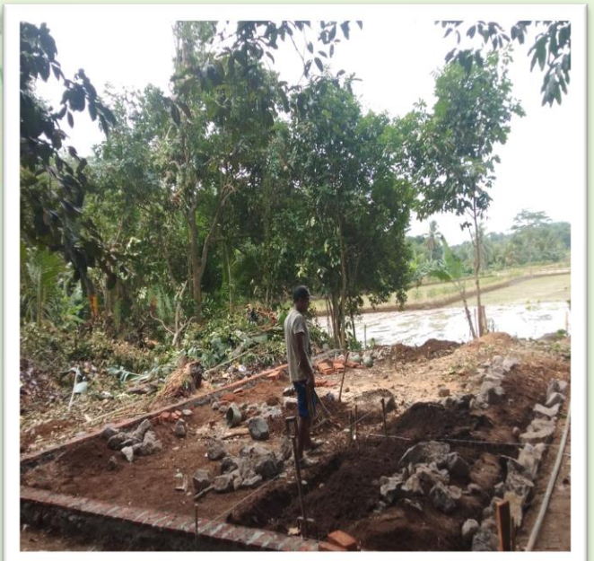
Pembangunan Pondasi Luas 6 x 14 M2
