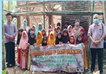
Pembangunan Asrama RPTQ Cab. Banten
